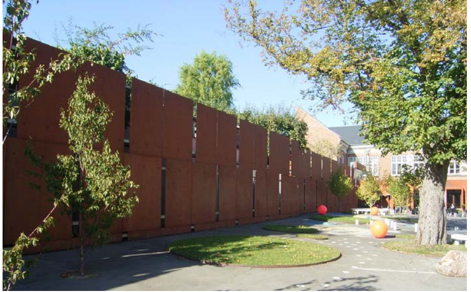
Inspiration. Væg af jernplade og beplantning. Kultursted i Kolding af Dorte Mandrup Arkitekterne
